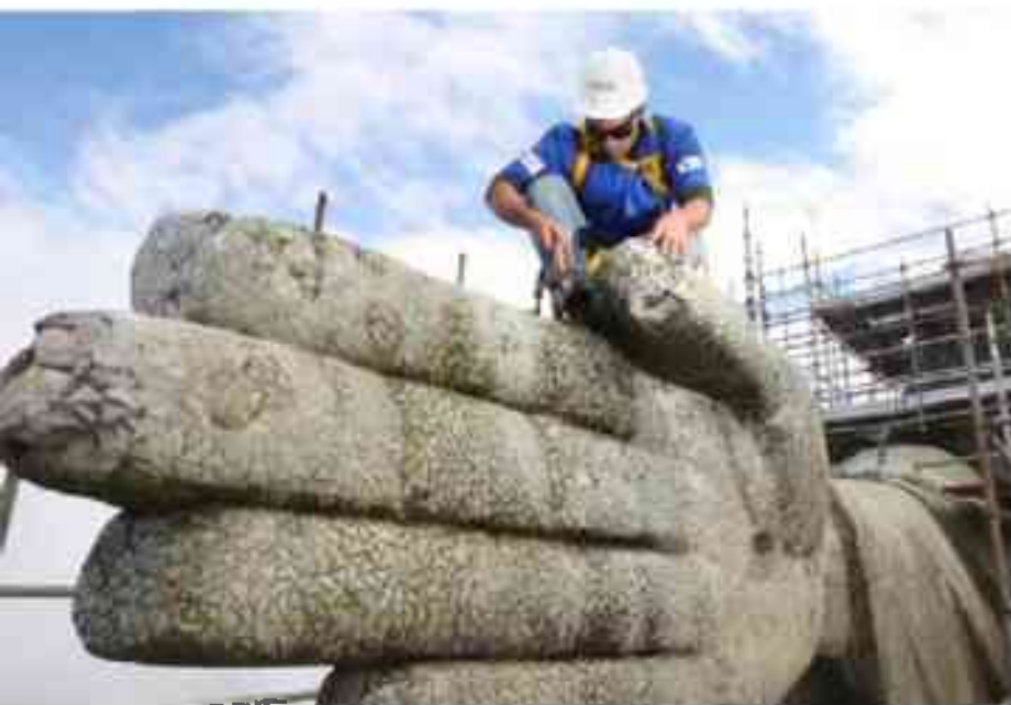
A munkások manualisan távolítottak el a durva szennyeződések a zöldesen csillogó zsírkőhejbol. A vasbeton a természetes kő-mozaik alatt fekszik.
