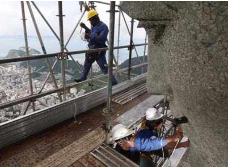
Az AQUA-STOP W® UNIVERSAL használata nagyon egyszerű: az oldatot ecsetekkel viszik fel a kőre.
